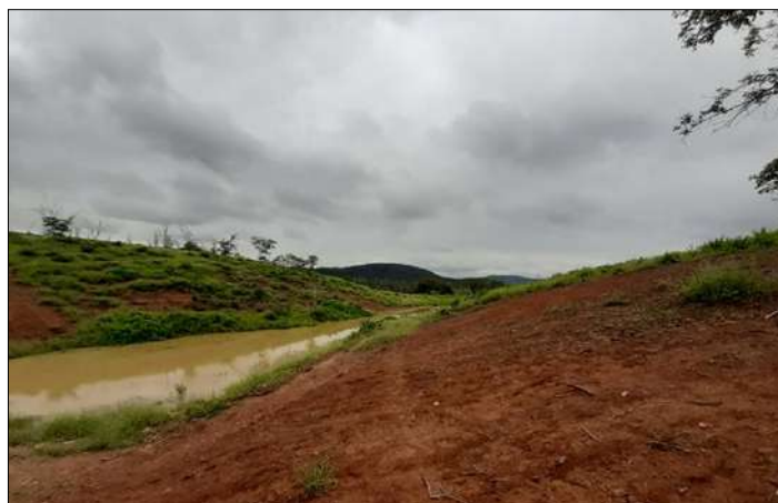
Figura 105 – Vista geral de barramento presente na área de intervenção ambiental.
