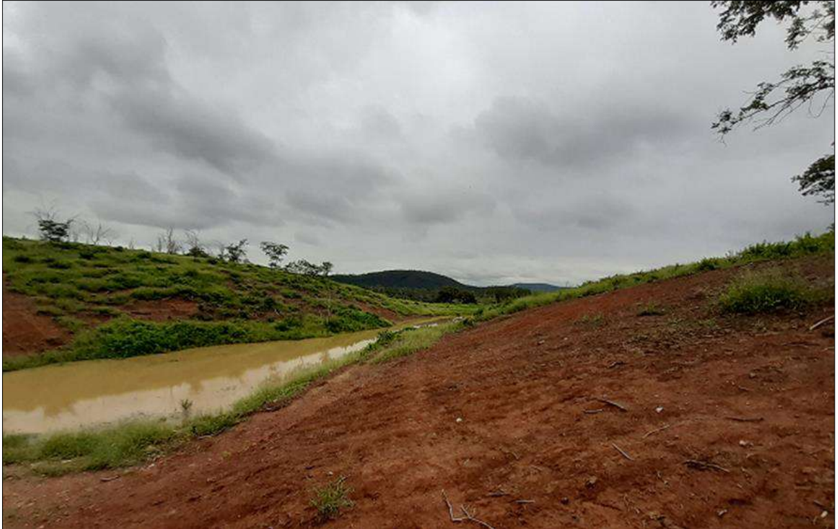
Figura 100 - Barramento em propriedade rural circundado por campo antropizado com poucas árvores isoladas. Fonte: Vetor Ambiental e Urbanística, 2020
